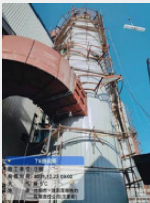
图：浑南热力脱硫塔改造
