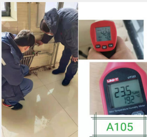
图：工人为暖气管道排气&学生宿舍测温结果
