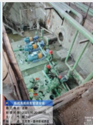
图：浑南热力脱硫系统 配套供浆管道安装
