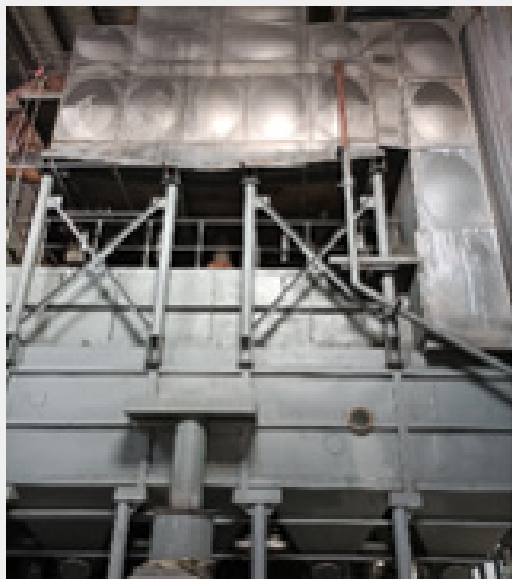
图：脱硫改造工程
